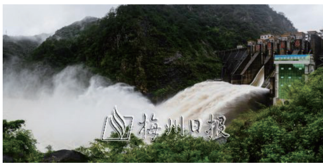
長潭大壩多個泄洪閘門已打開，滔滔不絕的洪水宛若銀龍從溢洪道飛流直下。(李樂忠 攝)
